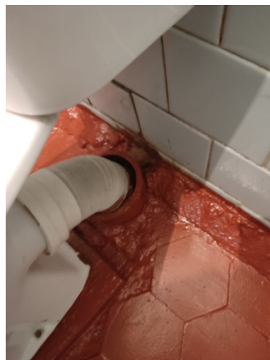
Фото 7.9.3.8 Разгерметизация/износ трубопроводов
