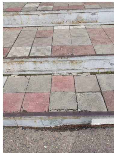
Фото 7.6.2 Разрушение плитки
