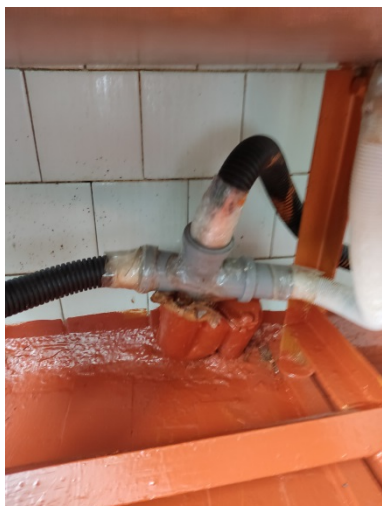
Фото 7.9.3.7 Ремонтные участки трубопровода
