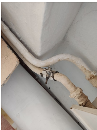
Фото 7.9.1.9 Ремонтные участки трубопровода
