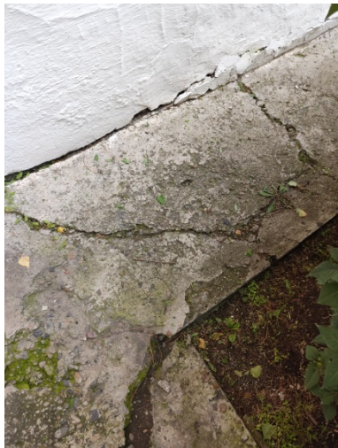
Фото 7.1.1 Разрушение отмостки
