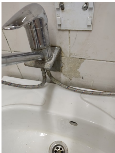
Фото 7.9.2.3 Износ санитарно-технических приборов
