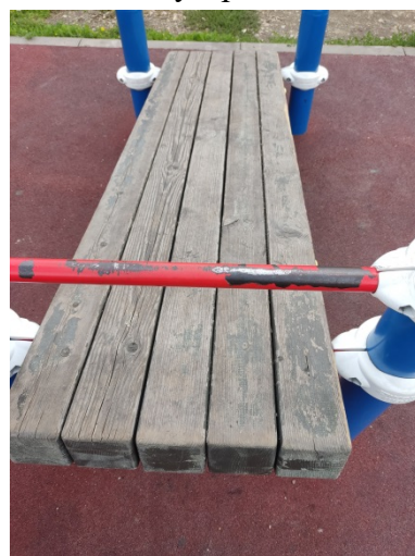
Фото 7.7.8 Износ элементов благоустройства
