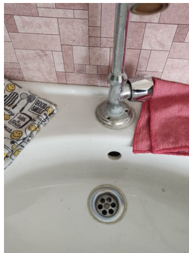
Фото 7.9.2.2 Износ санитарно- технических приборов
