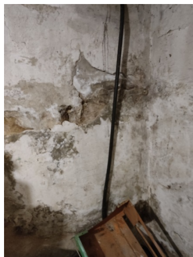
Фото 7.2.38 Следы увлажнения/размораживания
