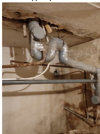
Фото 7.9.3.12 Ремонтные участки трубопровода
