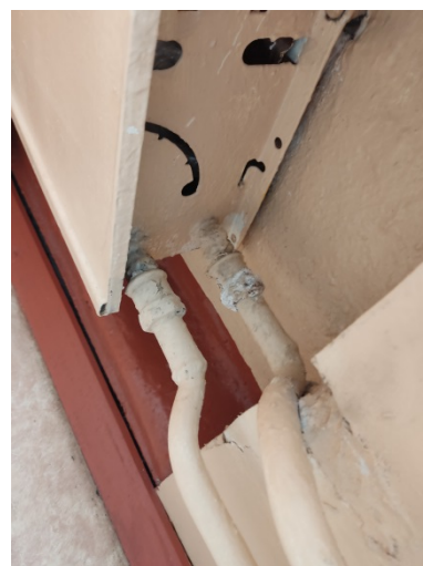
Фото 7.9.1.4 Многократное окрашивание/износ приборов отопления
