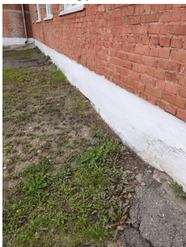
Фото 7.1.3 Разрушение отмостки
