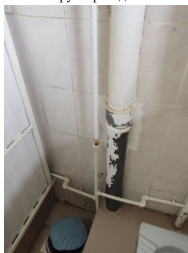
Фото 7.9.3.4 Разгерметизация/износ трубопроводов
