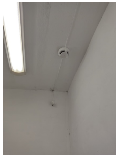
Фото 7.9.6.6 Открытая прокладка/провисание линий сетей связи/износ датчиков сигнализации
