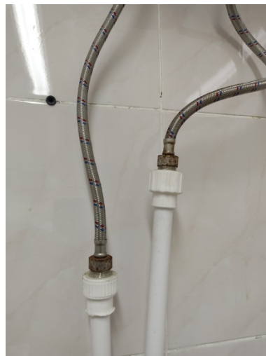
Фото 7.9.2.4 Коррозия трубопроводов
