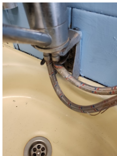
7.9.2.12 Коррозия трубопроводов
