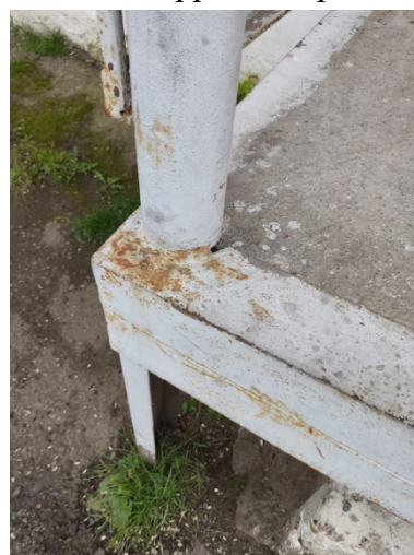
Фото 7.6.6 Коррозия каркаса
