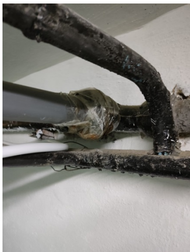
Фото 7.9.3.13 Ремонтные участки трубопровода
