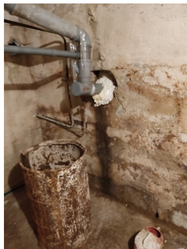
Фото 7.9.3.14 Отсутствие герметизации выпуска
