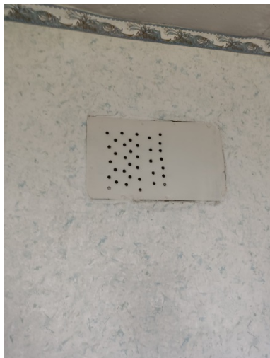
Фото 7.9.5.1 Закрашивание/заклеивание вент каналов
