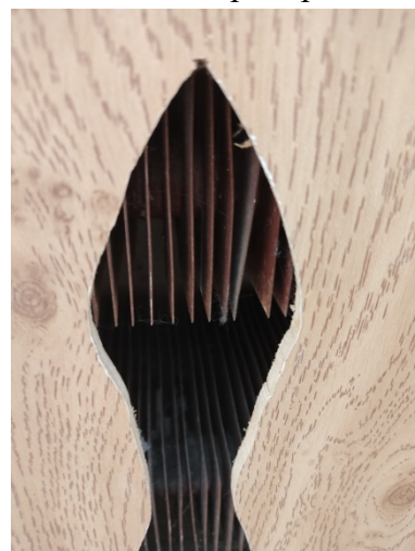
Фото 7.9.1.6 Коррозия/износ приборов отопления
