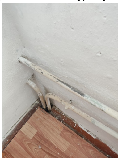
Фото 7.9.1.3 Коррозия/износ трубопровода
