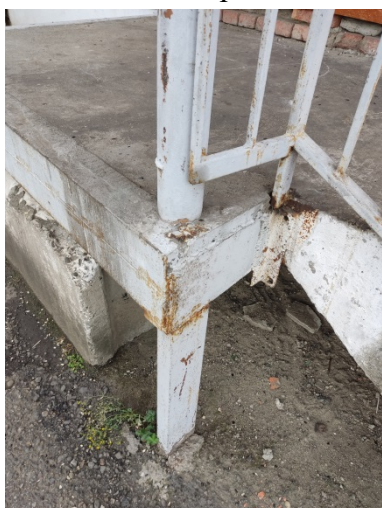
Фото 7.6.5 Коррозия каркаса
