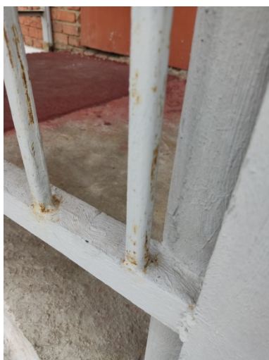
Фото 7.6.9 Коррозия ограждений
