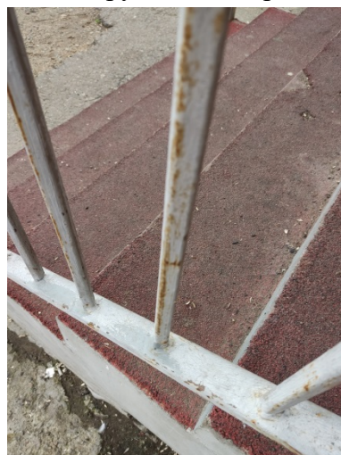
Фото 7.6.12 Коррозия ограждений
