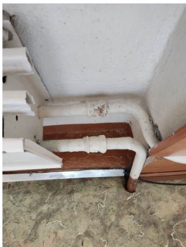
Фото 7.9.1.13 Коррозия/износ трубопровода
