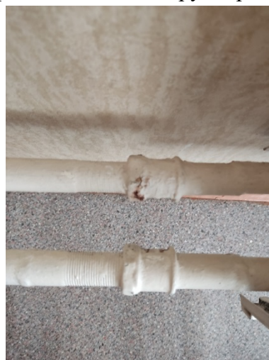
Фото 7.9.1.12 Коррозия/износ трубопровода
