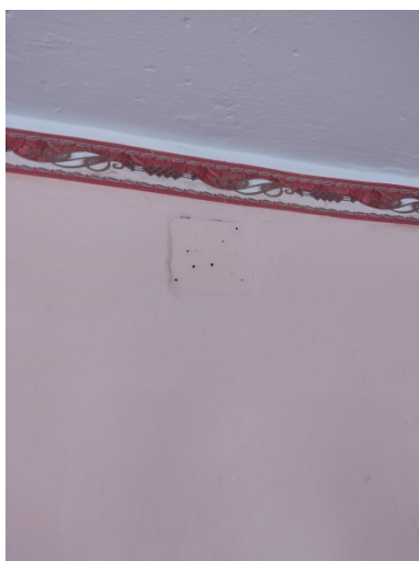
Фото 7.9.5.13 Закрашивание/заклеивание вент каналов
