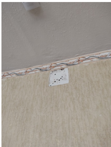
Фото 7.9.5.17 Закрашивание/заклеивание вент каналов
