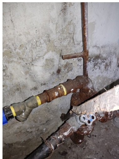
7.9.2.14 Коррозия трубопроводов
