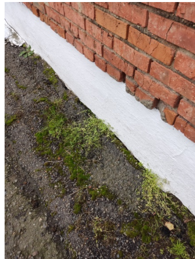
Фото 7.1.2 Разрушение отмостки
