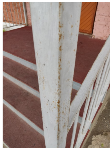
Фото 7.6.4 Коррозия ограждений
