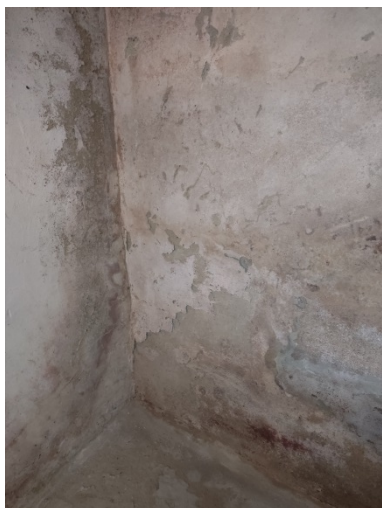
Фото 7.2.39 Следы увлажнения/размораживания
