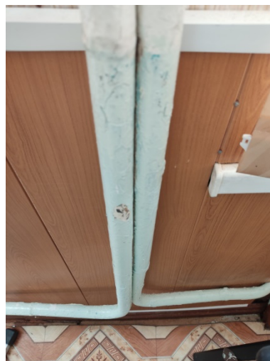
Фото 7.9.1.14 Коррозия/износ трубопровода
