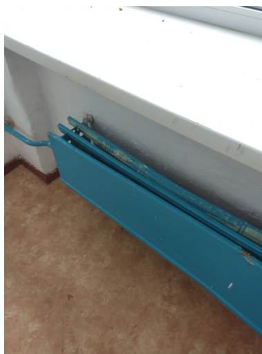
Фото 7.9.1.15 Многократное окрашивание/износ приборов отопления
