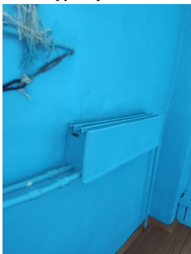
Фото 7.9.1.11 Многократное окрашивание/износ приборов отопления
