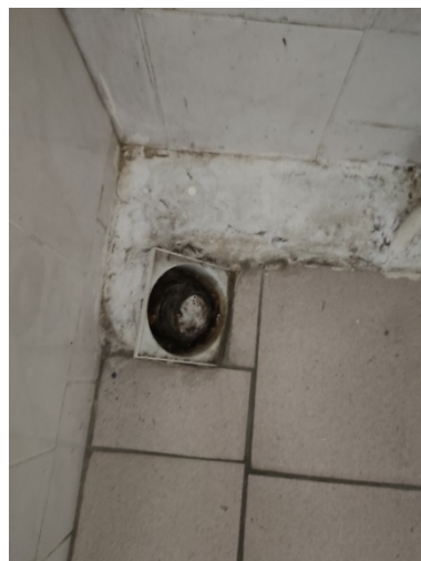
Фото 7.9.3.2 Разгерметизация/износ трубопроводов
