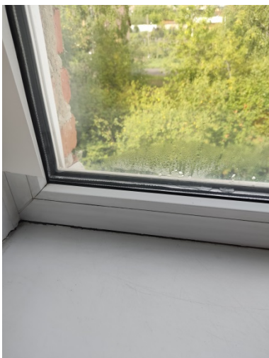
Фото 7.8.1 Нарушение герметичности стеклопакета
