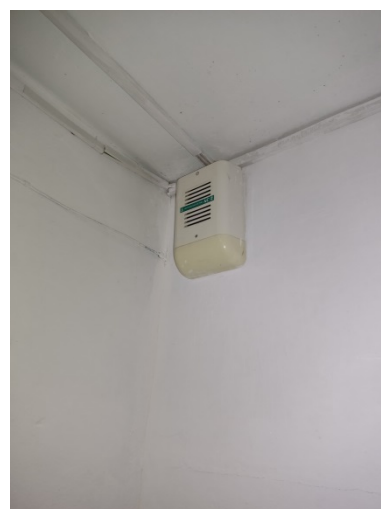
Фото 7.9.6.6 Открытая прокладка/провисание линий сетей связи/износ датчиков сигнализации
