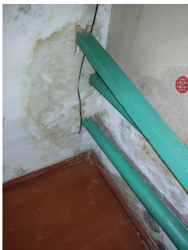
Фото 7.2.37 Следы увлажнения/размораживания
