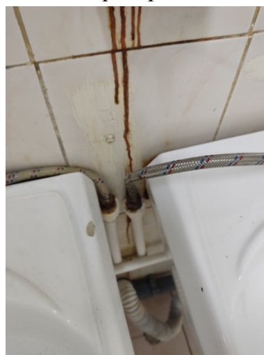
7.9.2.10 Коррозия трубопроводов
